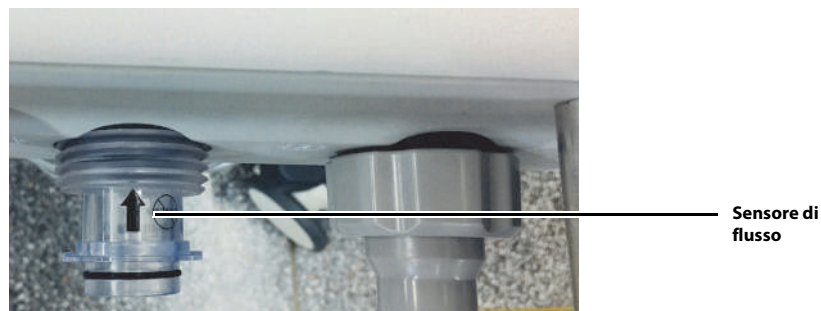
Figura 3-5 Installazione del sensore di flusso
